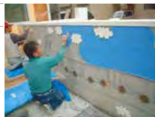
テクノカラーで広い面のコテ塗り
