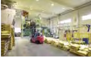
1号機 袋詰用の自動生産ライン(ロボット)
