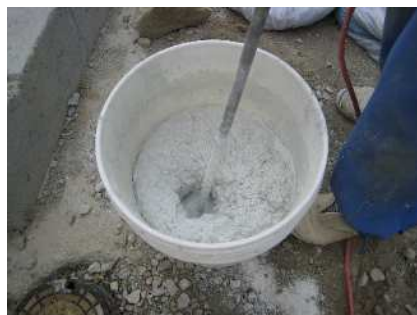
テクノカラーFW練り混ぜ状況
