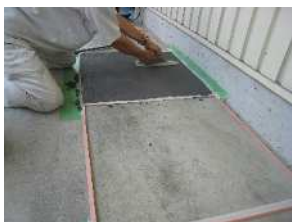
工程①所定の厚みに均す
