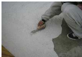
下地にガリガリとこすりつける
