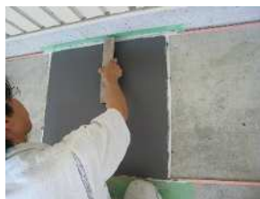
工程②刷毛引きで仕上げる
