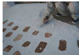
所定の厚みに均し仕上げます
