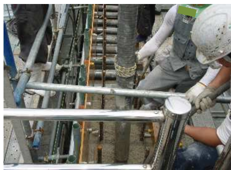
硬化後～14日以内にコンクリート打設
