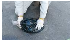
⑦ 空気を抜き、混ぜ残り・ダマが無いように揉んで混ぜる
