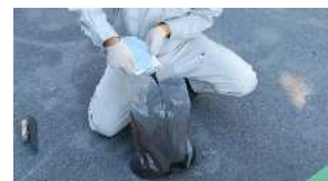
④ 骨材袋に樹脂液を投入
