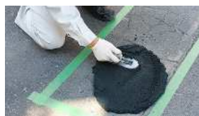
⑨ 金ゴテを用い、平滑になるように敷き均す
