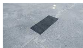
⑩ 養生を撤去して完成
