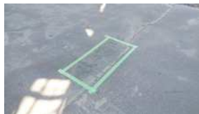
② 施工面のマスキング
