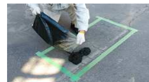
⑧ 施工面に材料を流し込む
